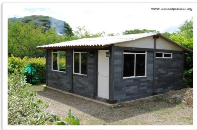
Casa construida con ladrillo de plástico reciclado
